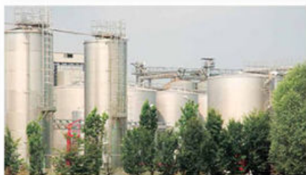
Fig. 5.12 Planta de biodiésel. La implementación de energías alternas a las derivadas del petróleo y de bajo nivel de contaminación ya está en desarrollo.
