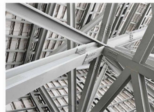
Fig. 2.42 Los elementos de soporte en muchas construcciones son de acero.
